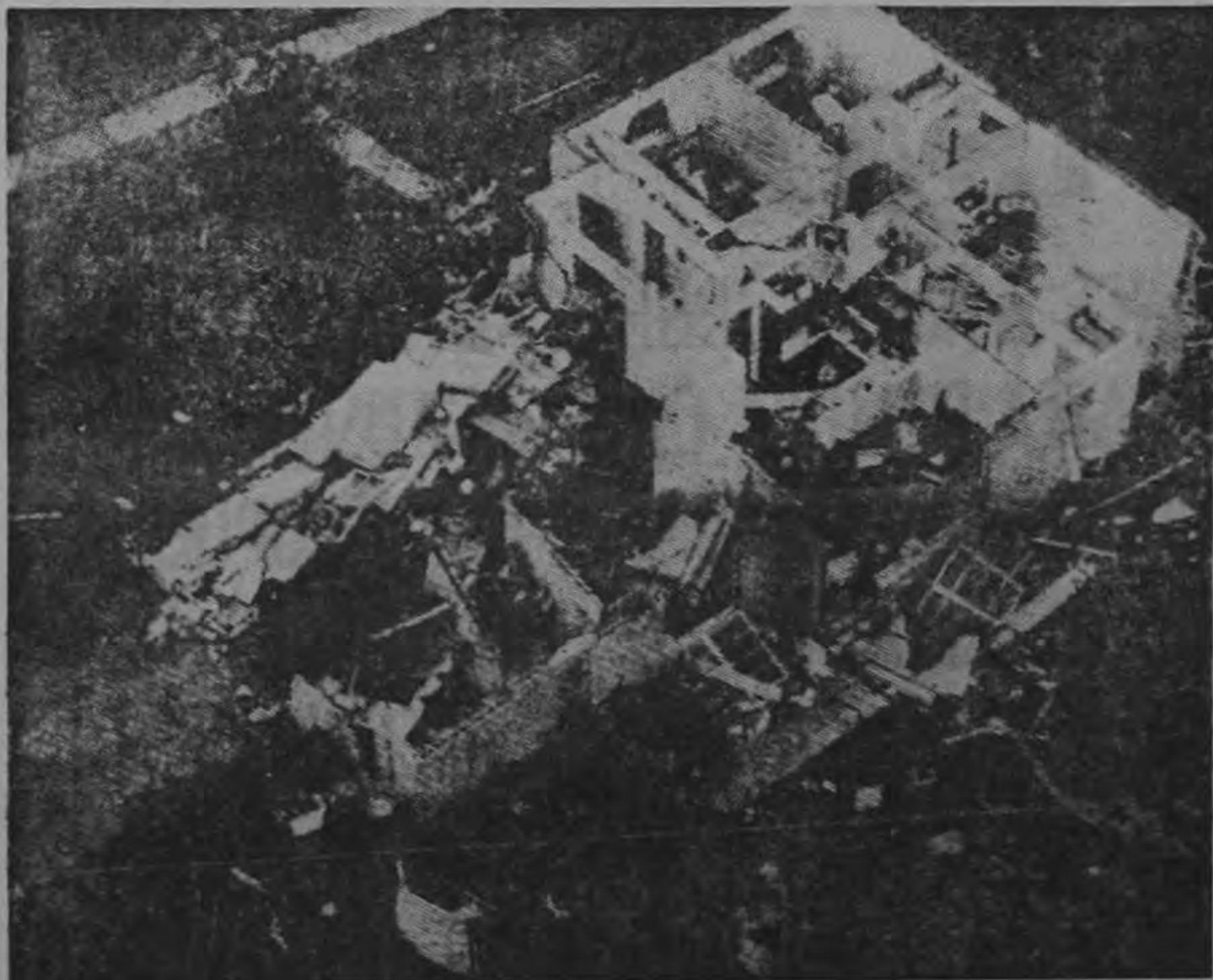
El techo de esta casa de Tampa, fue volado completamente por la fuerza del tornado que azotó la región, con tremenda violencia. Más de 30 millones de dólares se señalan como pérdidas.
