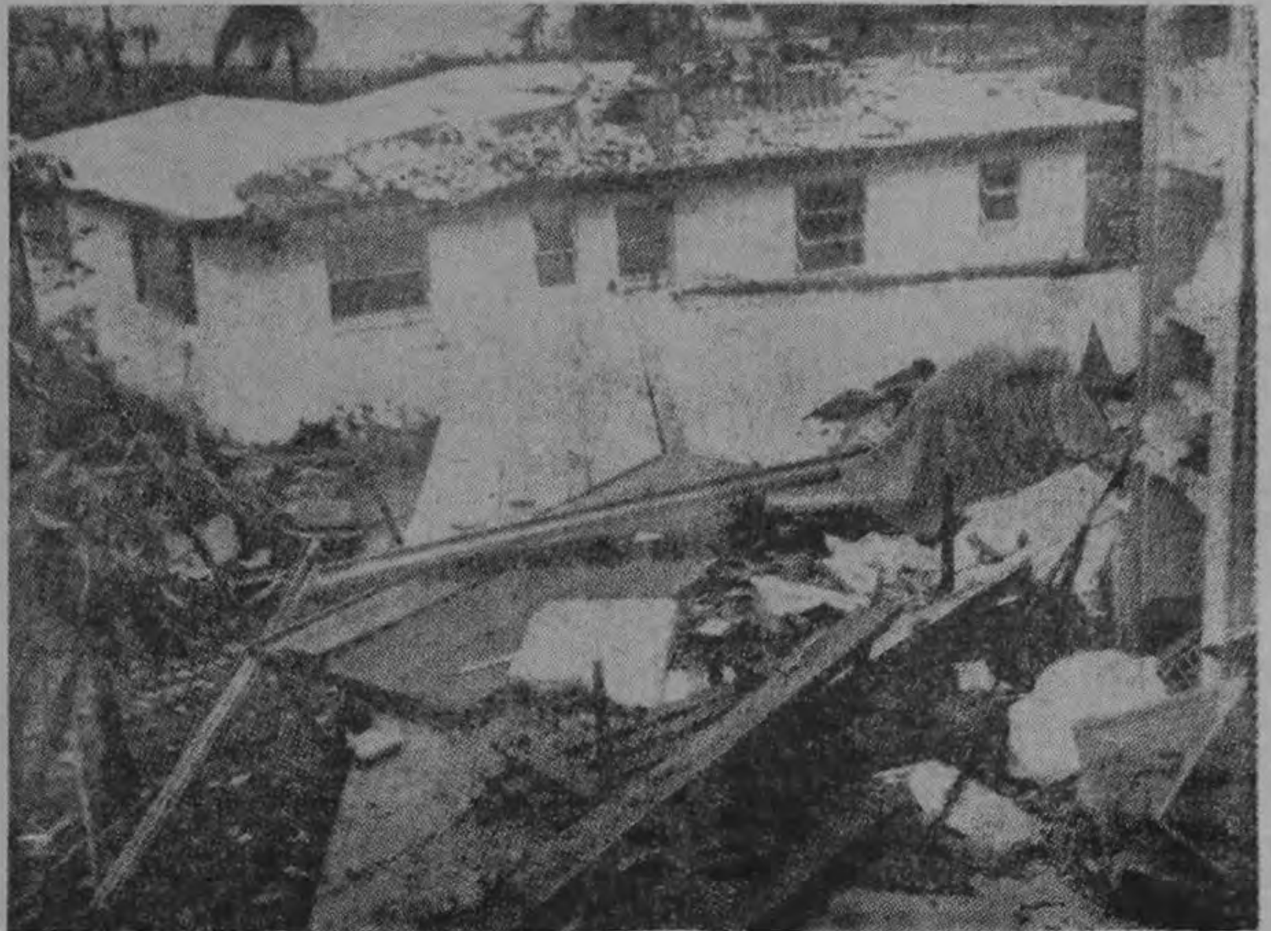
En Pineblas Point el tornado destruyó casas y toda clase de construcciones. Esta foto del lugar muestra los estragos. El sur de La Florida fue muy afectado.
